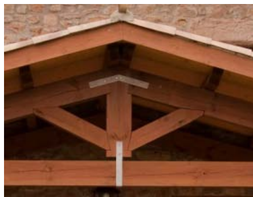
Figura B.29: Imatges d'encaixos de compressió de barbeta i rebaix en una encavallada.
