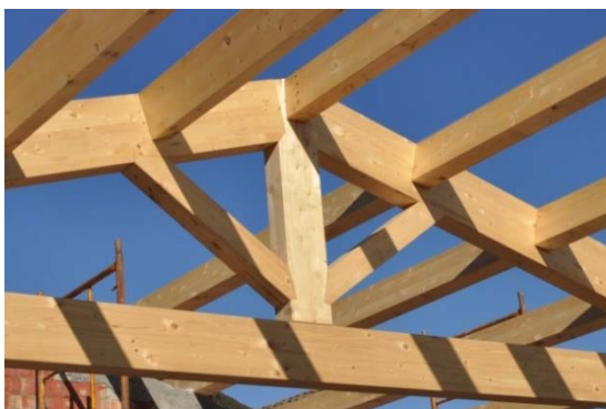
Figura B.29: Imatges d'encaixos de compressió de barbeta i rebaix en una encavallada.
