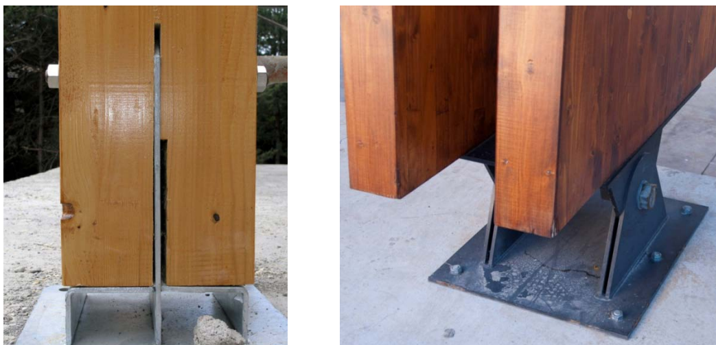
Figura B.9: Detall de punt de connexió entre un pilar i una fonamentació.
