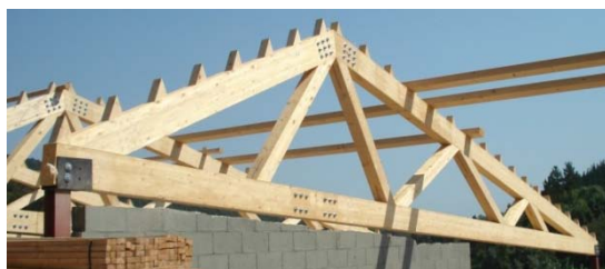
Figura B.7: Imatges de sistemes d'estructures pesades, tipus pòrtic (esq.) i tipus encavallada (drt).
