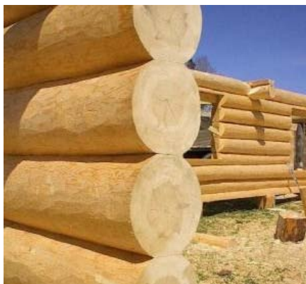
Figura B.15: Imatges de cases construïdes amb mur de troncs.
